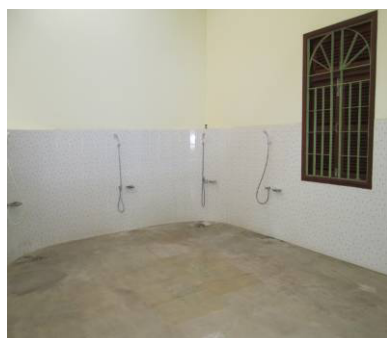
D 施設内のシャワールーム
